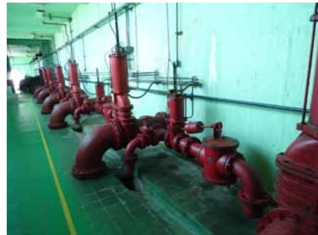
Ilustração 5.9 – ETA Pureza – Vista da galeria dos barriletes dos filtros
