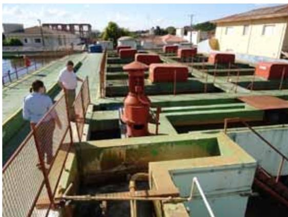
Ilustração 5.7 – ETA Pureza – Vista dos floculadores mecânicos
