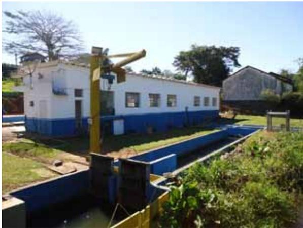
Ilustração 5.2 – Captação do feijão - Vista em primeiro plano do gradeamento e canal de desarenação. Em segundo plano prédio de abrigo dos conjuntos motobomba
