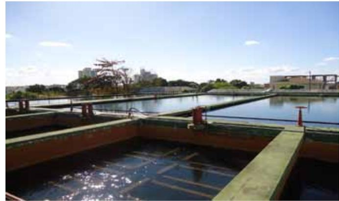
Ilustração 5.8 – ETA Pureza – Vista geral dos módulos de tratamento- Filtros em primeiro plano e decantadores convencionais em segundo plano.
