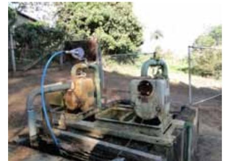
Ilustração 6.2.: Elevatória que requer manutenção
