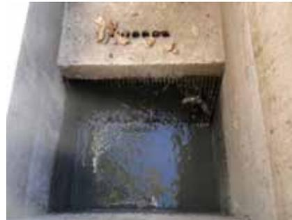
Ilustração 6.1.: Grade corroidanachegada elevatória
