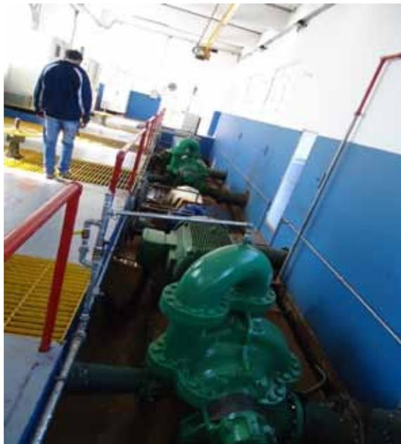
Ilustração 5.3 – Captação do feijão - Vista interna do prédio de abrigo dos conjuntos motobomba com destaque para conjunto recém implantado
